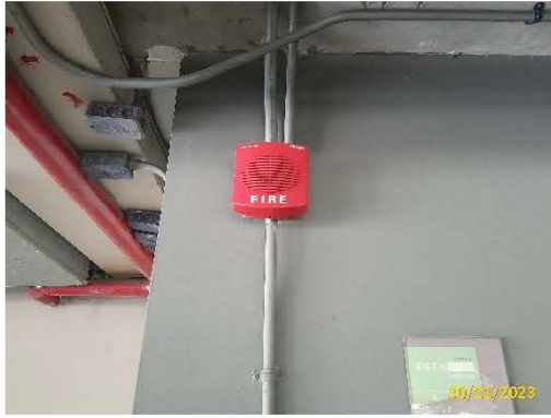
อุปกรณ์ส่งสัญญาณเตือนแจ้งเหตุเพลิงไหม้
