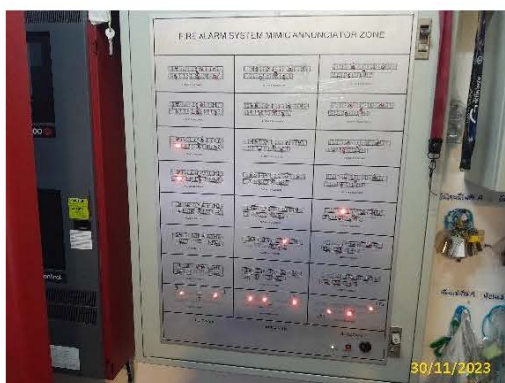
แผงควบคุมระบบสัญญาณเตือนเหตุเพลิงไหม้
