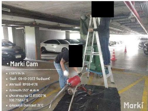
การสูบลูบตะกอนระบบบำบัดน้ำเสีย
