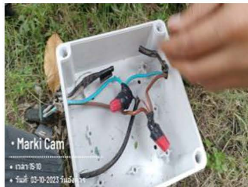
การซ่อมแซมอุปกรณ์และสายไฟฟ้า
