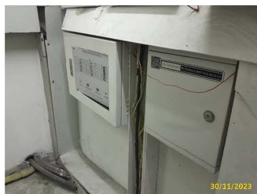
แผงควบคุมระบบสัญญาณเตือนเหตุเพลิงไหม้
